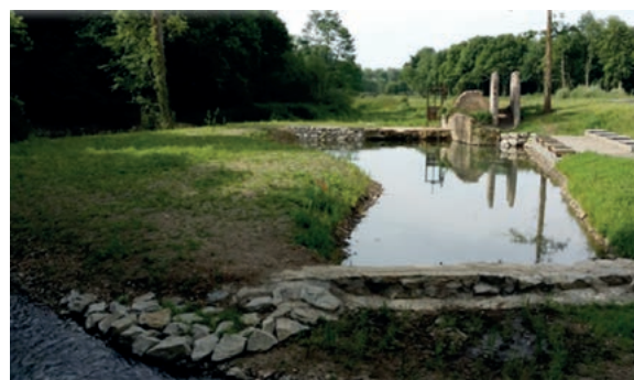
L'ouvrage OH17b démantelé : mise en valeur des vestiges de la forge et création d'un plan d'eau de pêche, en juin 2015.
