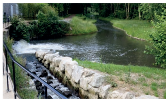
L'ouvrage OH13 conservé et équipé en rive droite d'une passe rustique en enrochement, en juin 2015.
