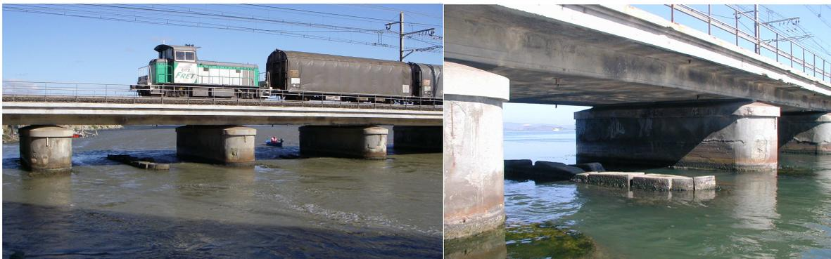
*Pont de la voie ferrée : les anciennes piles en pierres réduisent la section d'échange à 59 m<sup>2</sup> au débouché du grau dans l'étang. Leur enlèvement permettrait de retrouver une section de 100m<sup>2</sup>, équivalente à celle qui existe aujourd'hui au niveau de l'ancien barrage à vannes.*
