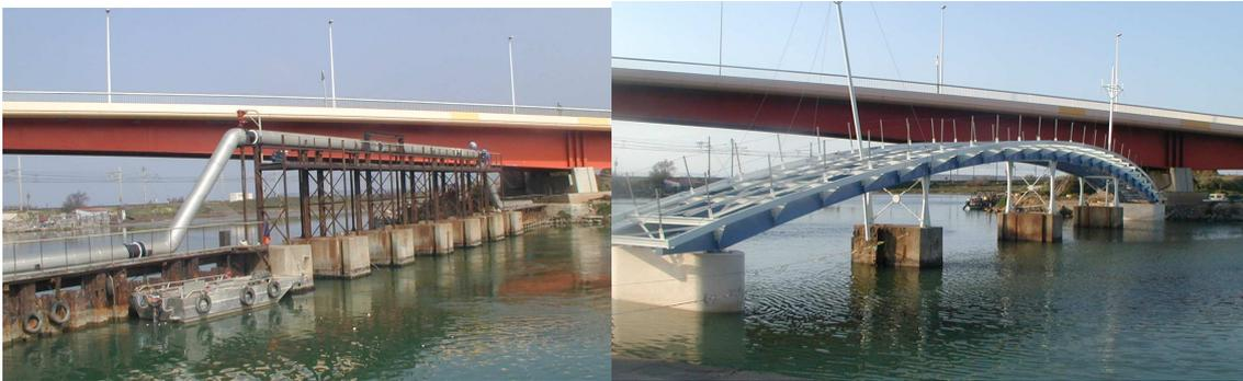
*Enlèvement du barrage à vannes en 2004 : la section dans le grau est passée de 54m<sup>2</sup> à 102m<sup>2</sup> à cet endroit*
