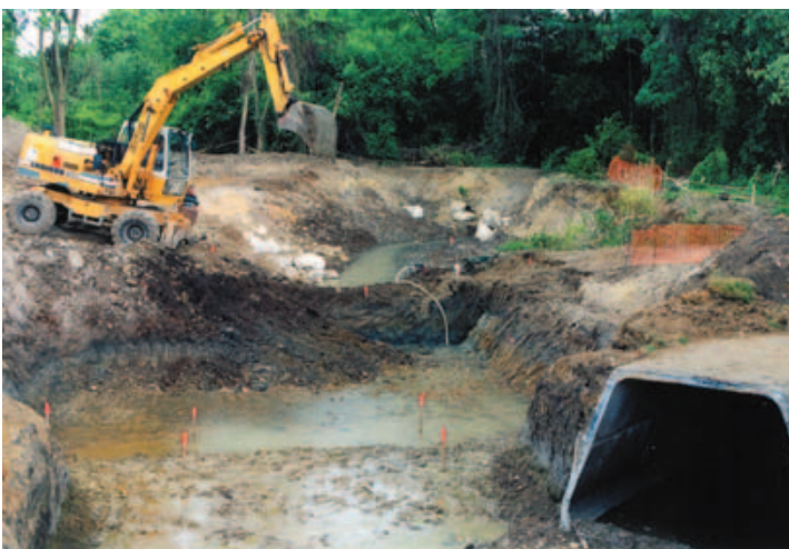
Le Parc de Fresnes pendant les travaux - 2003
