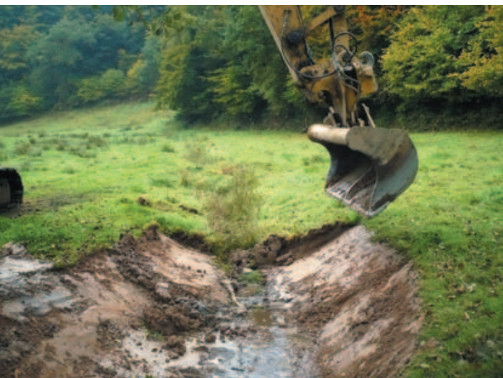
La phase de travaux de la restauration de la Doquette. Les berges sont travaillées alternativement. Octobre 2008.
