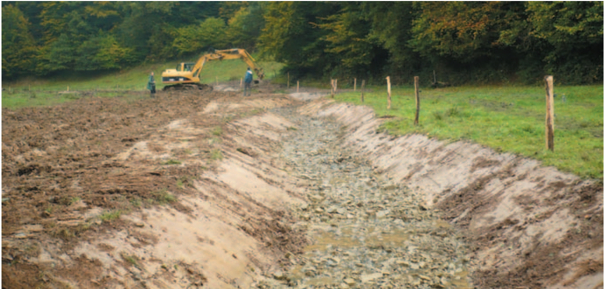
La phase de travaux de la restauration de la Doquette en octobre 2008 : reconstitution du matelas alluvial du cours d'eau par l'apport de matériaux grossiers.
