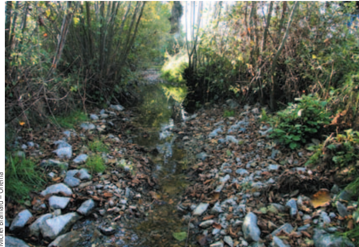
La Clouère, secteur L, lors d'un étiage sévère trois mois après les travaux.
