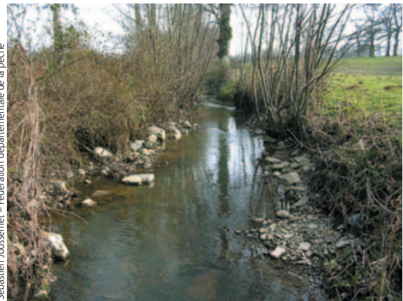
La Clouère, secteur L, dix mois après travaux.
