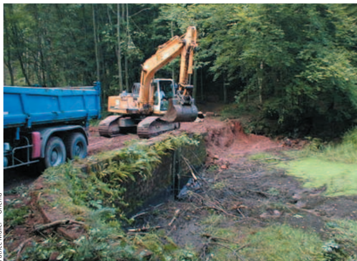
La suppression de la digue de l'étang de l'étang n°5, fin août 2008.
