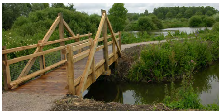
Passerelle en bois
