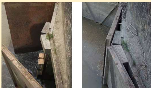
Photos 38 et 39 : Exemples de cales implantées sur des portes à flot (©MIGADO).
