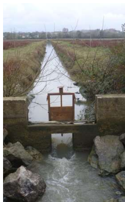
Photo 32 : Vue des écoulements au travers d'une vanne totalement ouverte.
