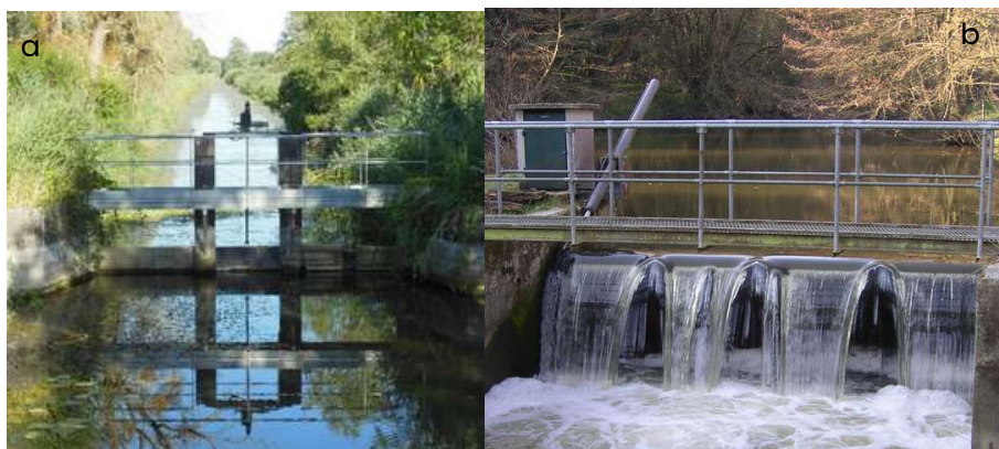
Photos 11 et 12 : Illustration d'un dispositif de vannage (a) et de clapet (b)
