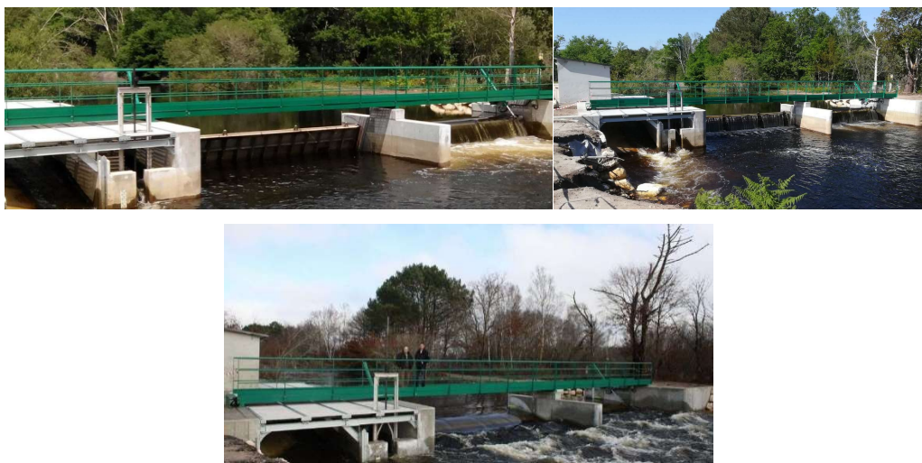
Photos 64, 65 et 66 : Illustrations de différentes conditions d'écoulement liées à l'hydrologie et aux modalités de gestion de l'écluse de Batejın sur le canal du Porge en Gironde (© SIAEBVELG).
