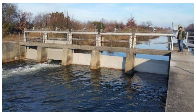
Photo 58 : Exemple de vannage avec un fort différentiel de hauteur d'eau générant des vitesses élevées et donc des conditions de franchissement difficiles pour la grande majorité des poissons (© SIAEBVELG).
