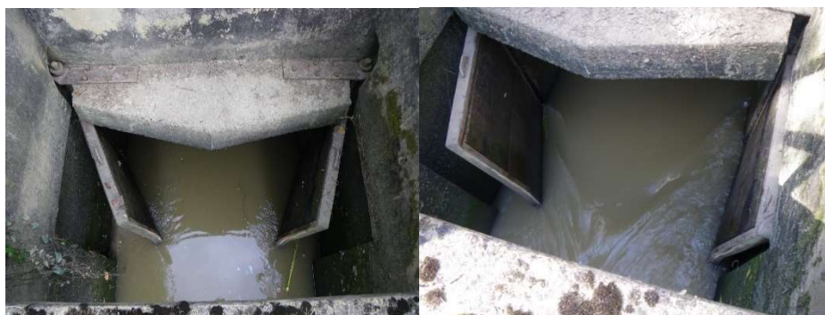
Photos 54 et 55 : Illustrations de conditions de vitesses permettant le franchissement d'une porte à flot (© ECOGEA).
