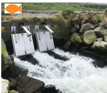
Photos 26 et 27: Vue des écoulements au droit d'une porte à flot et de clapets ouverts à marée basse dans une configuration de forts débits sortant générant de très fortes vitesses (@FDAAPPMA 33).
