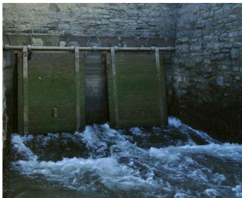
Photo 10 : Illustration de clapets reposant sur un radier incliné en aval infranchissable lorsque le niveau aval est bas.
