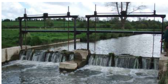
Photo 28 : Vue des écoulements en surverse au-dessus d'un vannage.
