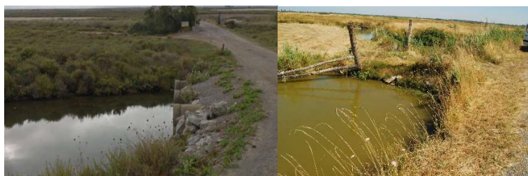
Photos 17 et 18 : Illustrations de passages busés et d'un passage pour l'accès à des parcelles.
