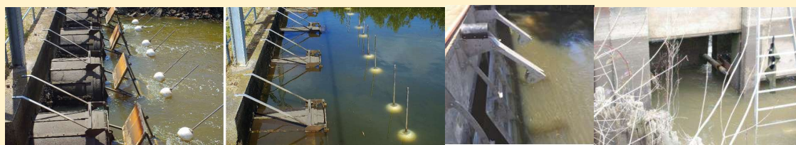
Photos 40, 41, 42 et 43 : Exemples de dispositifs retardateurs de fermeture implantés sur des portes à flot et des clapets (©Water Research Laboratory, UNSW Sydney ; SSA Environnemental ; MIGADO).
