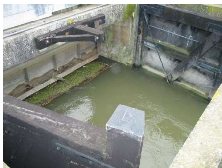
Photo 8: Ecoulements avec de faibles pertes de charge de des vitesses assez réduites lors de période d'ouverture de portes à flot. Les conditions hydrauliques sont compatibles avec le franchissement de certaines espèces de poissons.
