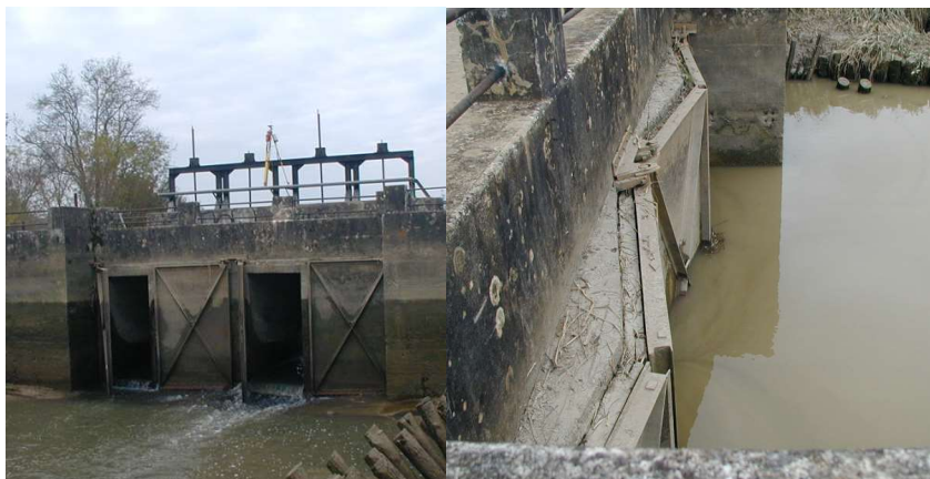
Photos 1 et 2 : Illustrations de portes à marée (portes à flot) ouvertes et fermées.
