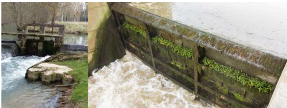
Photos 29 et 30 : Vues des écoulements en sousverse en dessous de vannages.
