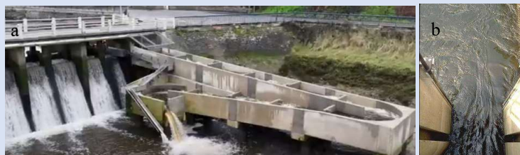
Photos 69 et 70 : Illustrations d'une passe à poisson avec une chute d'eau aval infranchissable à marée basse (a) et une absence de chute donc d'attractivité à marée haute (b).
