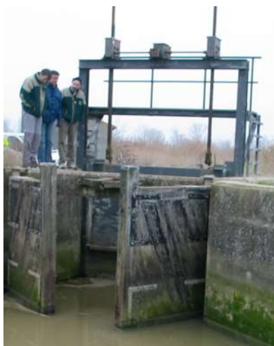
Photo 6 : Illustration d'un dispositif mixte avec porte à flot en aval et vanne en amont.
