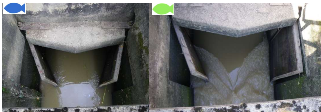
Photos 22 et 23 : Vue des écoulements au droit d'une porte à flot ouvertes dans 2 configurations de débits sortant générant des écoulements avec des vitesses différentes (©ECOGEA).
