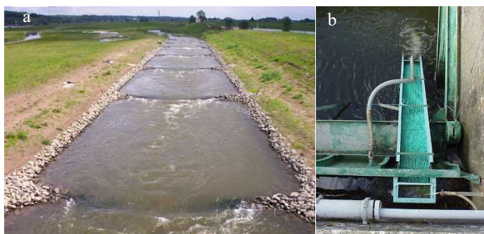
Photos 33 et 34 : Illustrations de 2 passes à poissons, l'une dimensionnée pour le passage des aloses sur le Rhin (a) et l'autre spécifiquement pour celui des civelles et des anguillettes (b) (© A. Scharbert et Observatoire du Patrimoine Naturel du Marais Poitevin).
