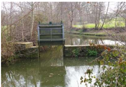
Photo 56 : Exemple de vannage totalement ouvert assurant la libre circulation des poissons (© T. Besse LOGRAMI).
