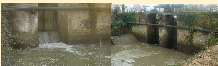
Photos 47 et 48 : Exemple de gestion par surverse et par sousverse d'un vannage en amont d'une porte à flot (©OFB).
