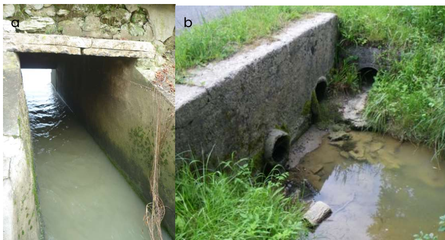
Photos 13 et 14 : Illustration d'un dalot (a) et d'une buse (b)
