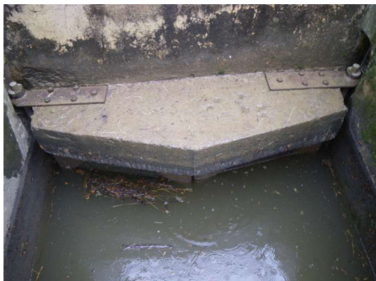
Photo 7: Illustration d'une porte à flot totalement fermée bloquant les échanges d'eau et donc le passage des poissons et des crustacés.
