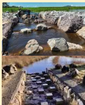
Photos 73 et 74 : Illustrations rampes en enrochement (©Catchment solutions - FDAAPPMA 33).
