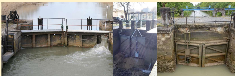
Photos 35, 36 et 37 : Exemples de vantes implantées sur des portes à flot.
