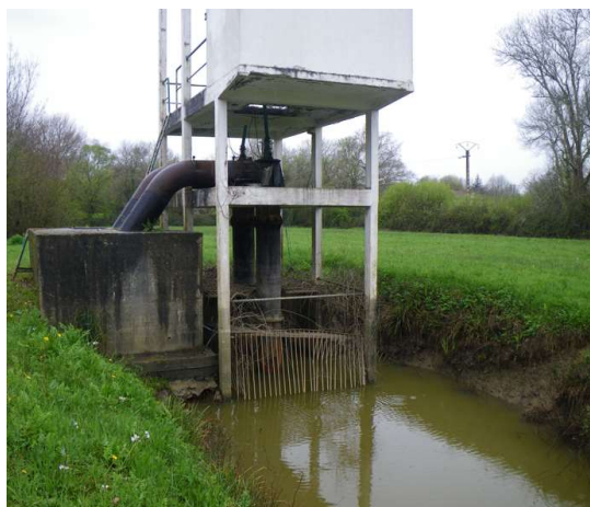
Photo 19 : Illustration d'un dispositif de pompage permettant d'évacuer les eaux d'un marais vers la mer.
