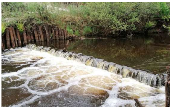
Photo 59 : Exemple d'un seuil avec des écoulements en jet plongeant obligeant les poissons à sauter pour le franchir limitant ainsi la libre circulation de beaucoup d'espèces (© SIAEBVELG)
