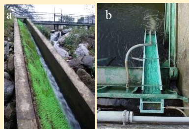
Photos 77 et 78 : Illustrations passe brosse à alimentation gravitaire (a) et (b) par pompage (@ECOGEA).
