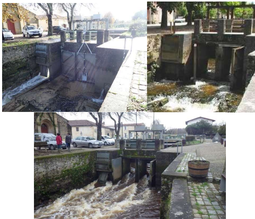
Photos 51, 52 et 53 : Illustrations de différentes conditions d'écoulement sur un même ouvrage du Saucat en Gironde pour 3 situations de débit sortant (©FDAAPPMA 33).
