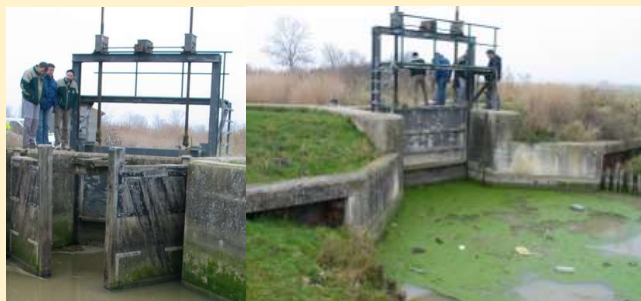
Photos 45 et 46 : Exemple d'ouvrage double avec des portes à flot et un vannage amont (©OFB).
