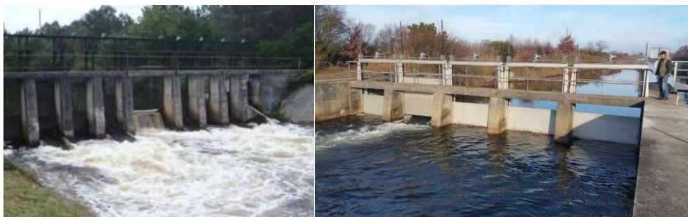
Photos 62 et 63 : Exemples de gestion différenciée de vannages sur des ouvrages du canal du Porge en Gironde générant une diversité de conditions d'écoulement en aval susceptibles d'influencer l'attractivité des poissons en migration (© SIAEBVELG).
