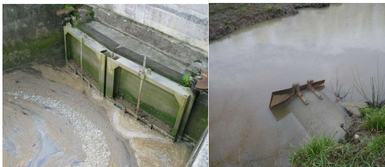
Photos 20 et 21 : Porte à flot et clapet totalement fermés lors du flot empêchant tout franchissement par les espèces utilisant le transport tidal sélectif.
