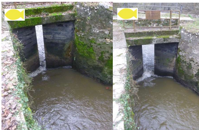
Photos 24 et 25 : Vue des écoulements au droit d'une porte à flot partiellement ouvertes dans 2 configurations de débits sortant générant des écoulements très instables ((@ECOGEA).
