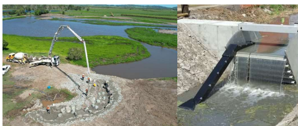
Photos 81 et 82 : Illustrations de deux configurations de passes à poissons avec des emprises foncières très différentes.
