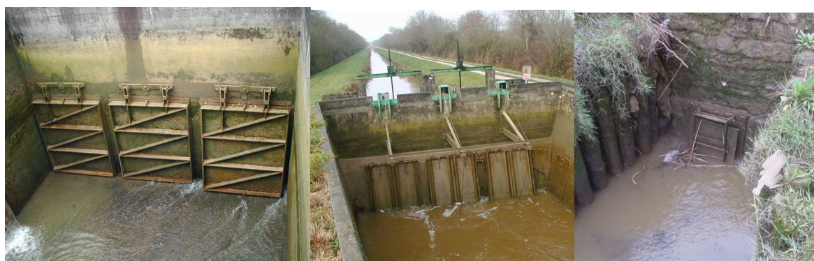
Photos 3, 4 et 5 : Illustrations de clapets en position ouverte et fermé.
