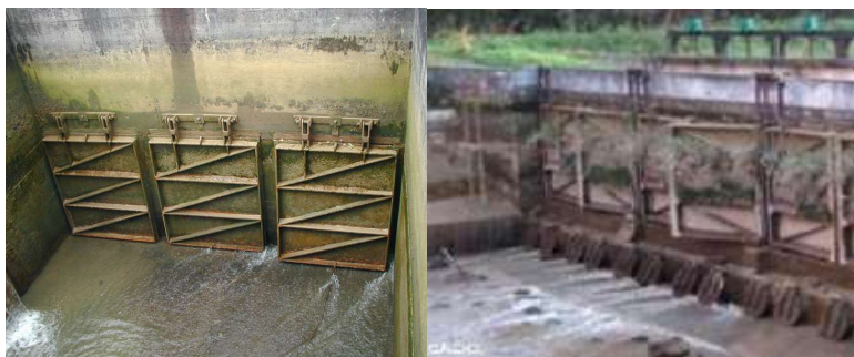
Photos 49 et 50 : Illustrations d'écoulement fortement pincés au niveau de clapets à marée (@MIGADO).
