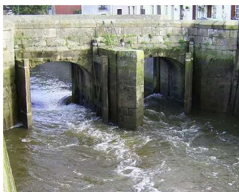
Photo 9 : Ecoulements à forts débits fluviaux avec une perte de charge marquée et des vitesses fortes pouvant limiter le franchissement de certaines espèces de poissons.
