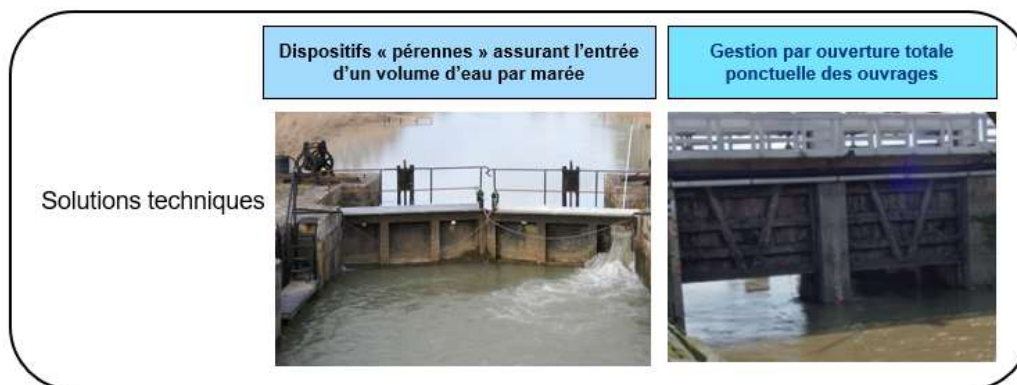
Figure 91 : Présentations des 2 stratégies de gestion des 1 ers ouvrages à la mer pour permettre la libre circulation des espèces migrant en utilisant le transport tidal sélectif.
