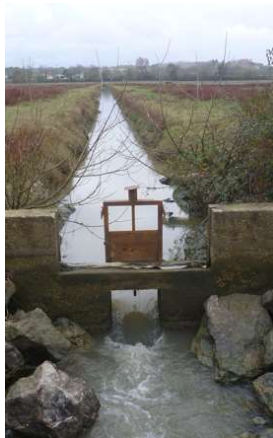
Photo 57 : Exemple d'une perte de charge au droit d'un vannage pourtant totalement ouvert (© ECOGEA).
