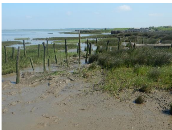
Figure 30 : Vestige d'une digue suite à une dépolderisation par abandon de la gestion sur une zone humide estuarienne dans le pays de Buch (Gironde).
