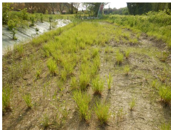
Figure 66 : Création d'une zone humide alluviale par excavation et plantation d'une haie avec un film plastique au sol dans un secteur de plateau dans le Grésivaudan (Isère). Aucun travail du sol après l'excavation n'a été réalisé, il n'est donc pas favorable à l'enracinement des végétaux.
