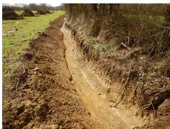
Figure 11 : Curage d'un fossé de drainage dans une zone humide alluviale en Bresse (Ain).
