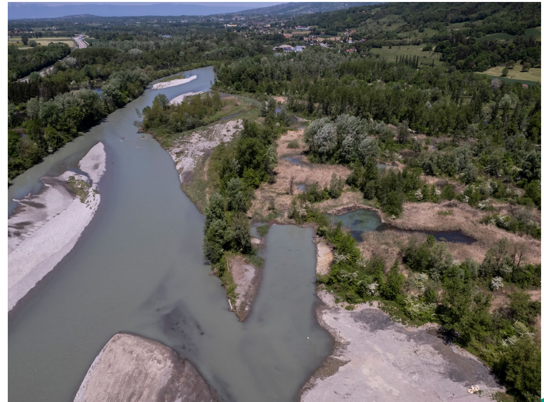
Mai 2022 – APRES TRAVAUX
