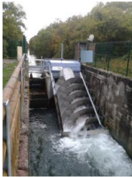
Turbines hydroélectriques compatibles avec le franchissement des poissons
