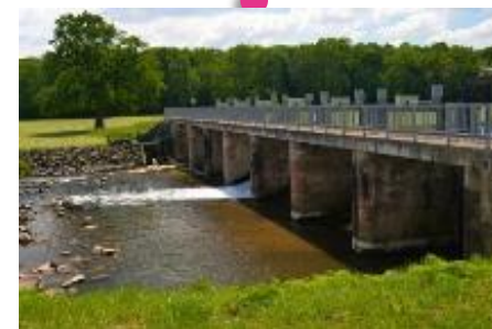
Ouvrage sur l'Ill régionale – Protection de Strasbourg contre les crues – Erstein
