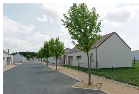
Indre, Levroux. Vue sur un lotissement
