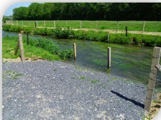
Exemple de descente stabilisée
