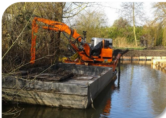
Exemple d'intervention à l'aide d'une drague à godet
