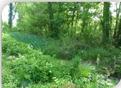
Contre-fossé totalement comblé en rive gauche sur le bief de Méricourt
