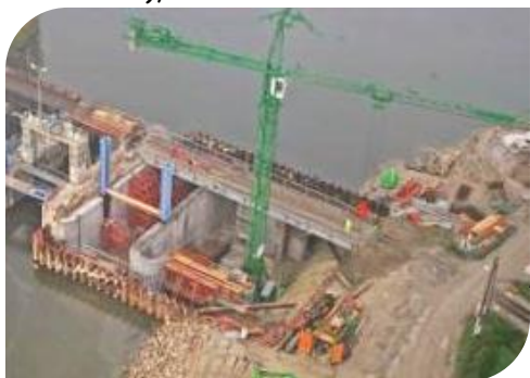
Construction d'une troisième passe sur le barrage inférieur de Saint Valéry
