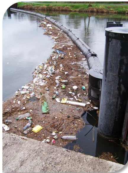
Concentration de déchets flottants sur le barrage de la Chaudière à Amiens
