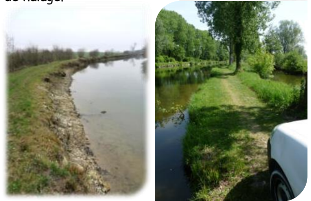
Glissements de rives consécutifs aux marnages
