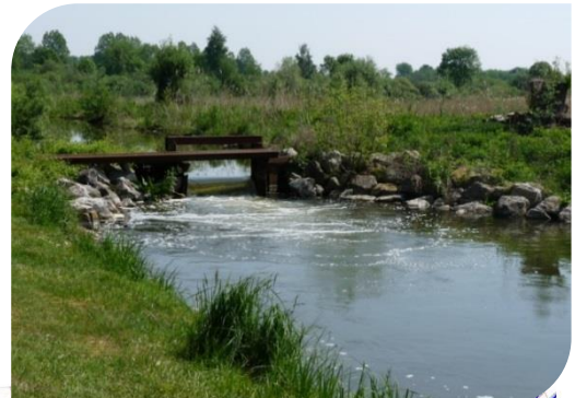
Seuil implanté sur le contre-fossé entre Etinehem et Méricourt
