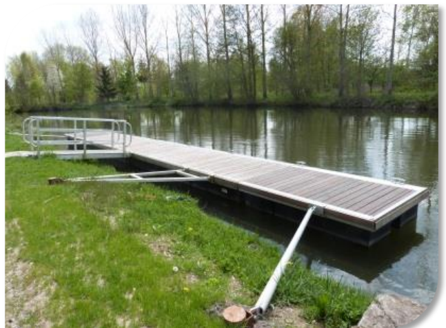
Exemple de ponton flottant sur le bief de Picquigny
