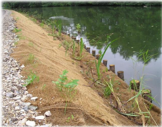
Exemple de risbermes mises en place en bordure du chemin de halage
