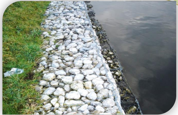
Exemple de confortement en matelas gabion
