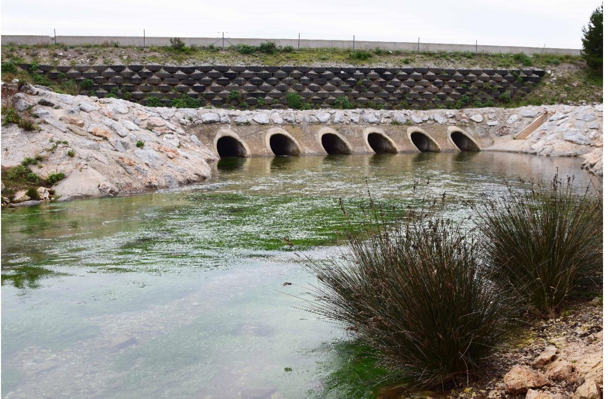
Busage sous l'Autoroute A6 pour le passage des eaux d'une résurgence karstique (cliché J. Ph. Siblet – Février 2017)
