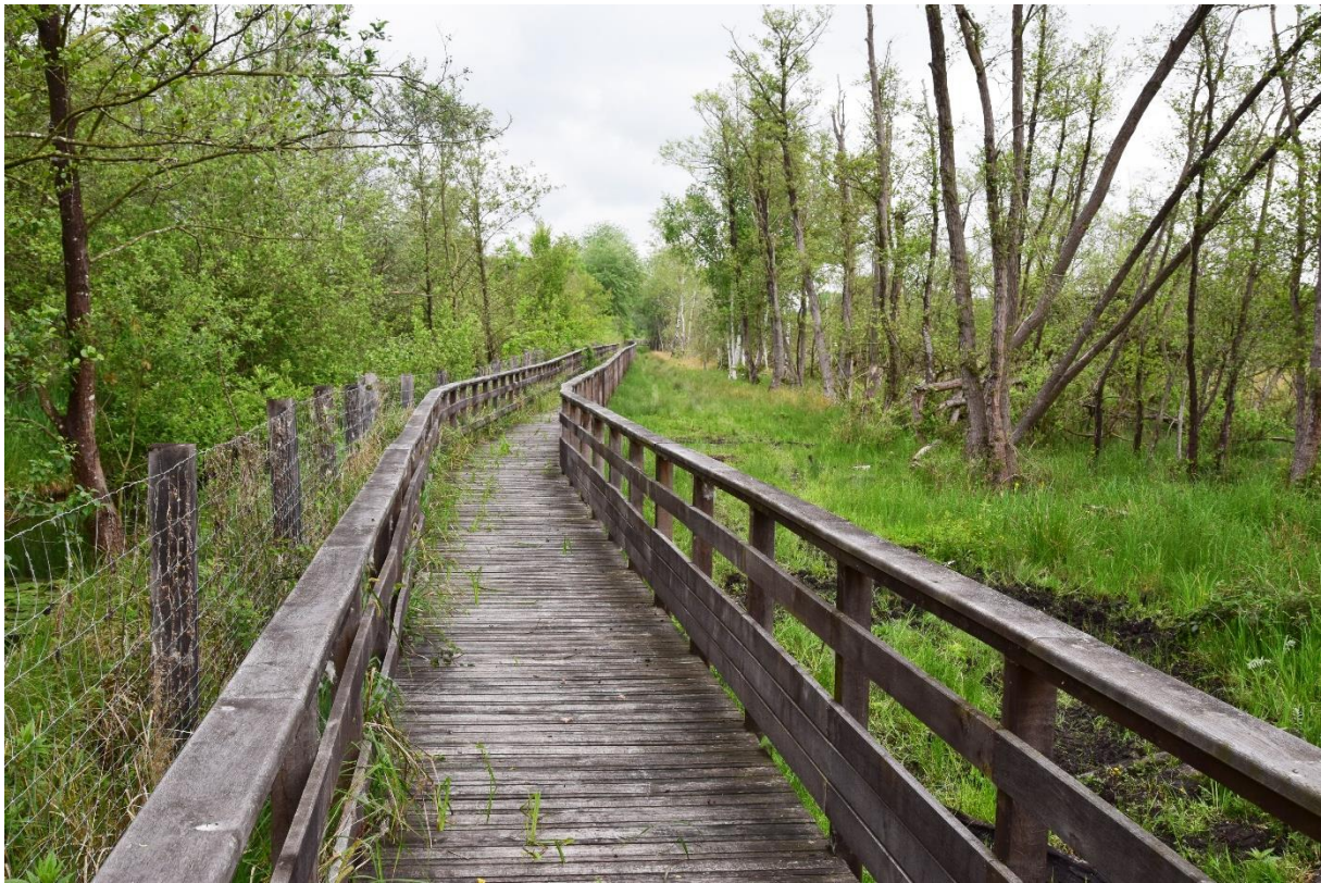
Sentier aménagé par le Conseil départemental de l'Oise (Cliché J. Ph. Sibley – Mai 2017)
