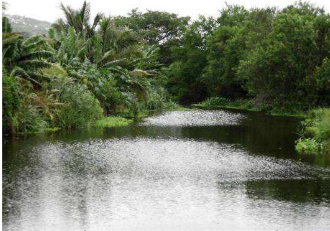
Figure 19 : Le canal Matoutia un des deux canaux principaux qui débouchent en amont du pont de la RN1. Source : Attié, 2012.
