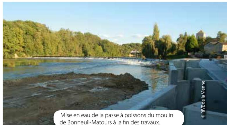
Mise en eau de la passe à poissons du moulin de Bonneuil-Matours à la fin des travaux.
