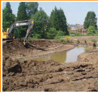
Pendant les travaux
