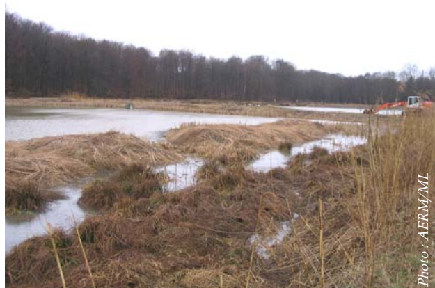
Exemple de diversification de la morphologie : création de hauts fonds et d'îlots sur l'étang n°2
