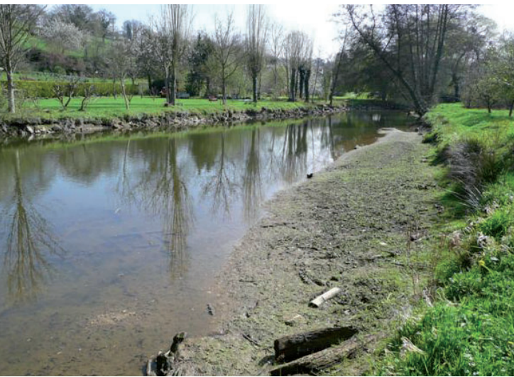
La retenue amont du seuil du moulin du bourg envasée, avant effacement. Juin 2011
