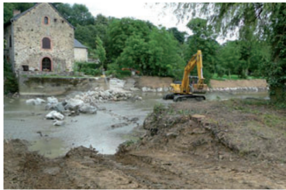
Dérèglement du seuil du moulin à la pelle mécanique. Juin 2011
