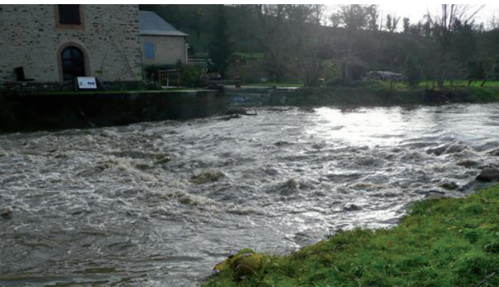
Accélération des écoulements, avec présence d'un ressaut et de fortes turbulences en pied de rampe lors des débits soutenus. Décembre 2011
