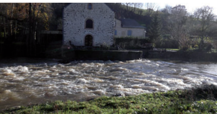
La modification de la rampe (allongement vers l'aval) permet d'effacer le ressaut et limite les turbulences observées (débit équivalent à l'année précédente). Décembre 2012
