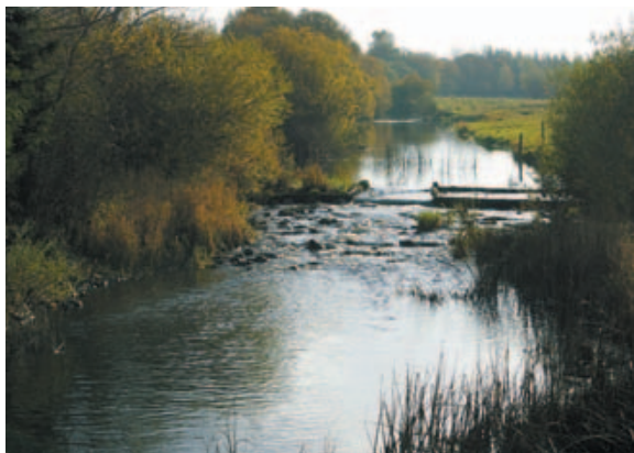
Remise en eau d'ancien méandre du Drugeon et conservation du lit rectifié. Un seuil de répartition permet la remise en eau du méandre (octobre 2008).
