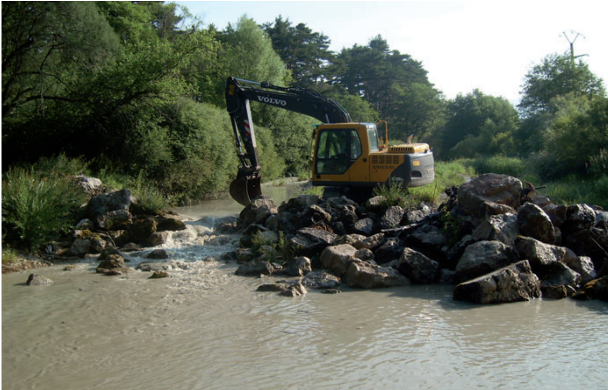
Arasement du seuil ROE43123 à la pelle mécanique. Juin 2009
