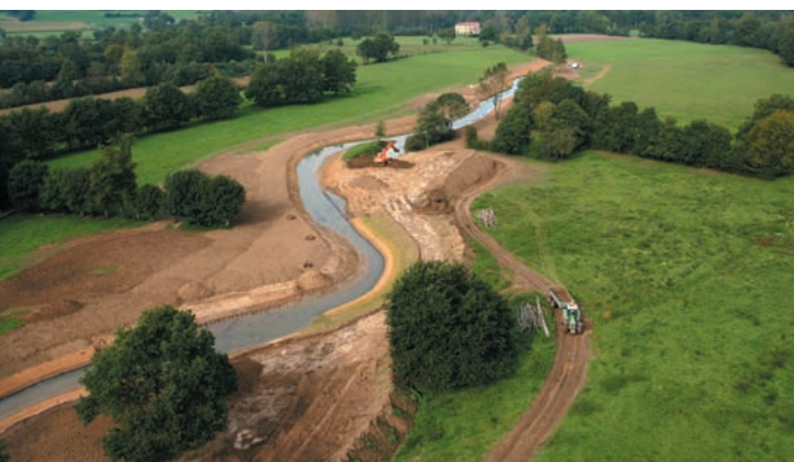
Les travaux de reméandrage sur la Petite Veyle en 2006. En haut : pose de banquettes végétalisées ; en bas : fin des travaux.
