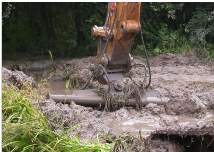
Extraction du drain
