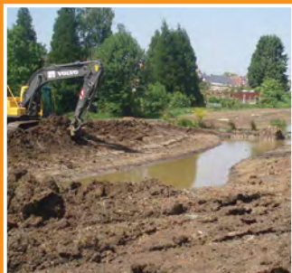
Pendant les travaux
