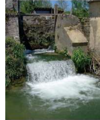
Agence de l'eau Artois-Picardie À gauche : ouvrage de M. Lafonte (ROE 26746) avec sa chute résiduelle de 2,06 m sur le bras de Bronne, à Aix-en-Issart. À droite : bras de contournement de l'ouvrage après travaux en juin 2015.
