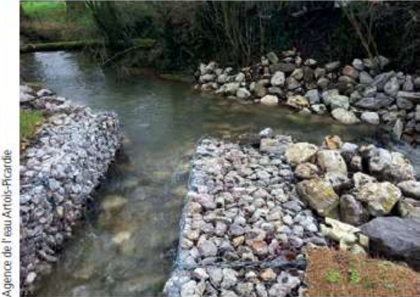
Agence de l'eau Artois-Picardie À gauche : ouvrage de M. Lafonte (ROE 26746) avec sa chute résiduelle de 2,06 m sur le bras de Bronne, à Aix-en-Issart. À droite : bras de contournement de l'ouvrage après travaux en juin 2015.
