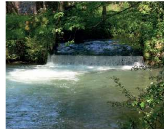
Agence de l'eau Artois-Picardie À gauche : ancien barrage de M. Houzel (ROE 26675) avec sa chute résiduelle de 0,95 m sur la Créquoise à Offin. À droite : effacement de l'ouvrage, après travaux en octobre 2014.
