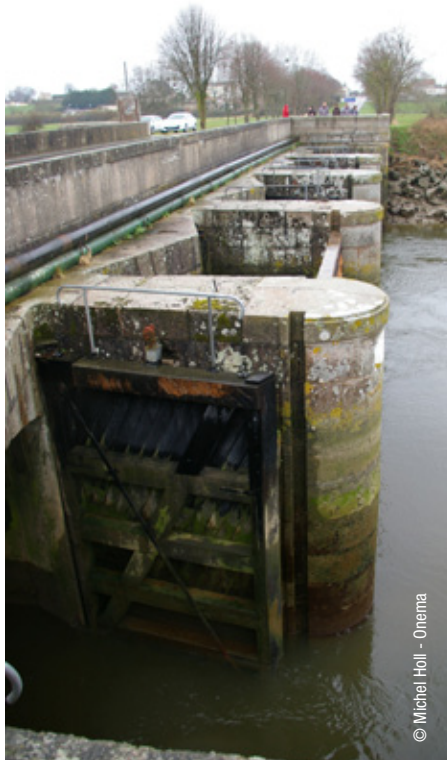
Ouvrage à la mer sur la Vire
